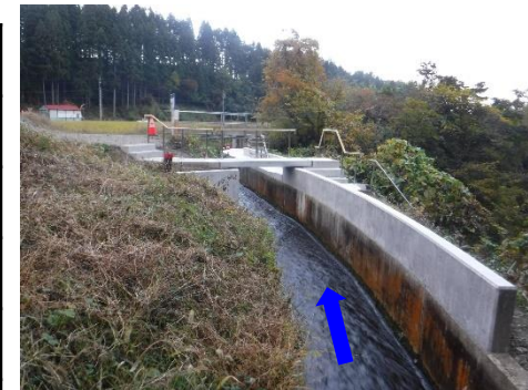
溢水対策状況(側壁嵩上げ) (水路Bから)
