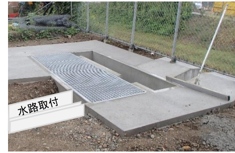
油水分離ます設置状況
