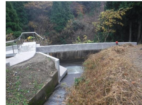
溢水対策状況(側壁嵩上げ) (水路Aから)
