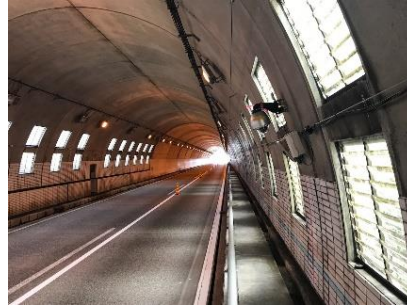
[交通監視カメラ設置]
