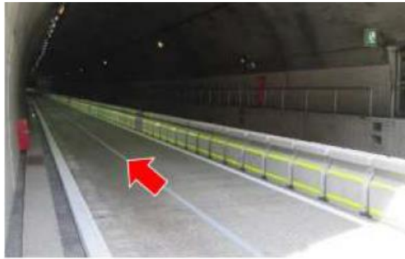
[対面通行規制および車線切替作業の状況]
