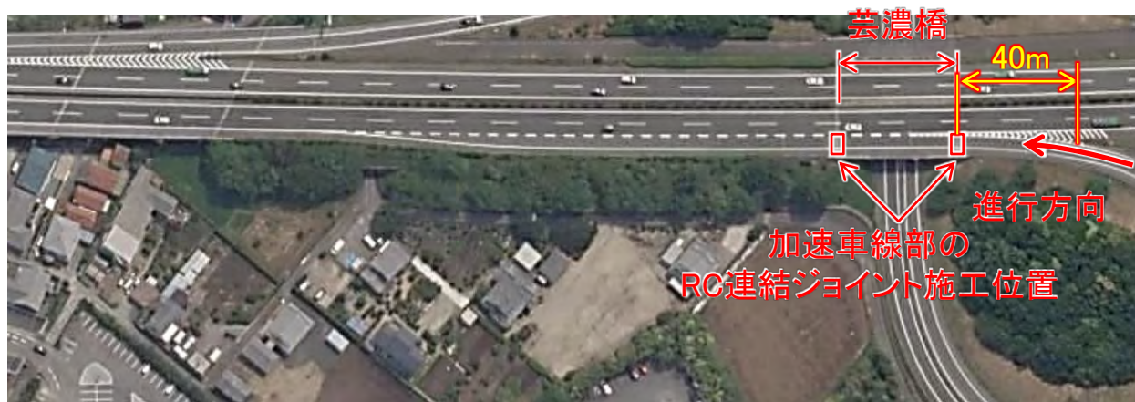
芸濃橋(上り線)航空写真
