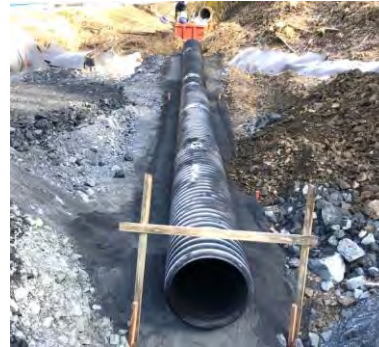
地下排水設置状況
