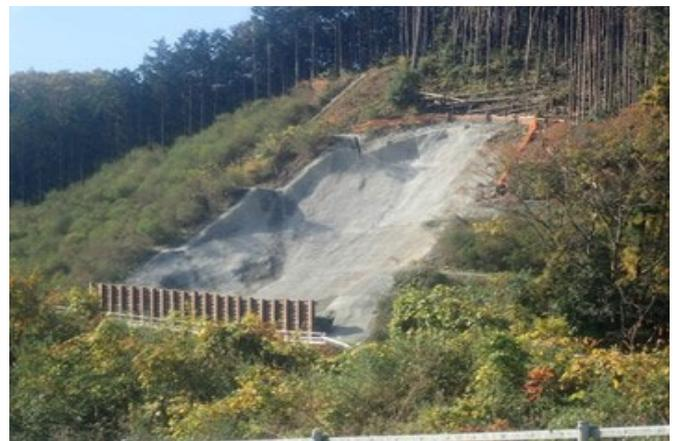
(斜面崩落の応急復旧の状況)
