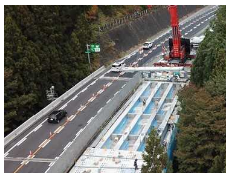
【キャップスラブ工法の施工状況写真】
