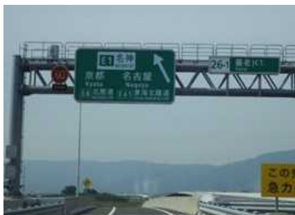
【JCT 分岐案内標識】
