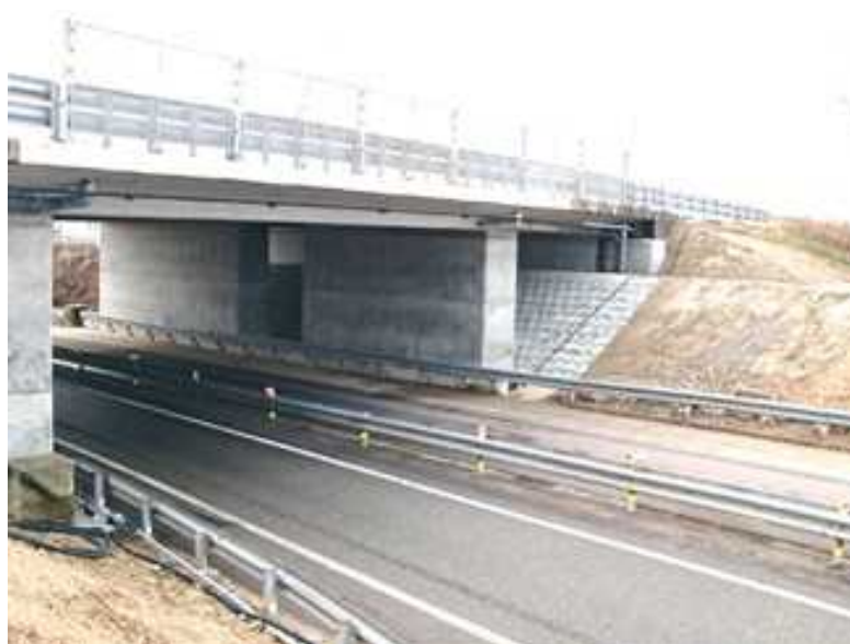
【E8 北陸自動車道 五郎丸橋 ロッキング橋脚】
