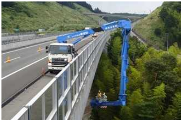
【橋梁の点検実施状況】
