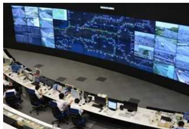
【道路管制センター】
