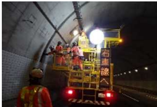
【トンネルの点検実施状況】
