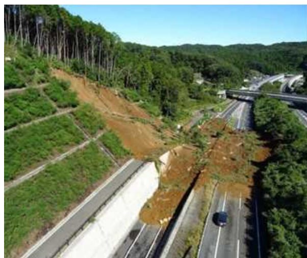
【C4 首都圏連絡自動車道 外回り 八王子西 IC 付近】
