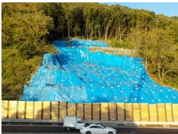
【E20 中央自動車道 上り線 43. 7KP 付近 】
