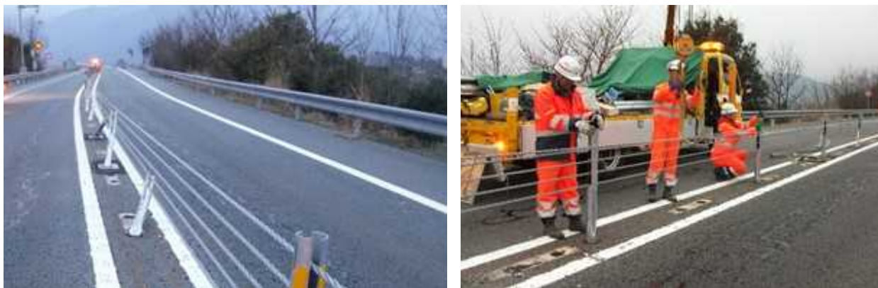
【交通復旧作業状況】
