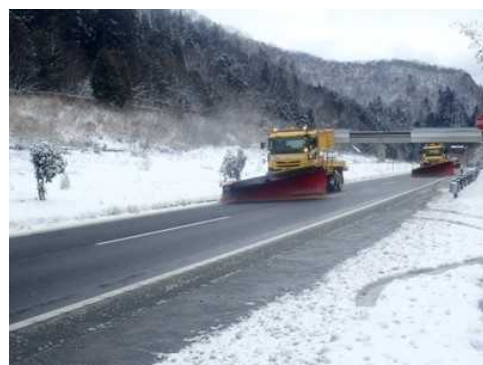
【除雪作業状況】
