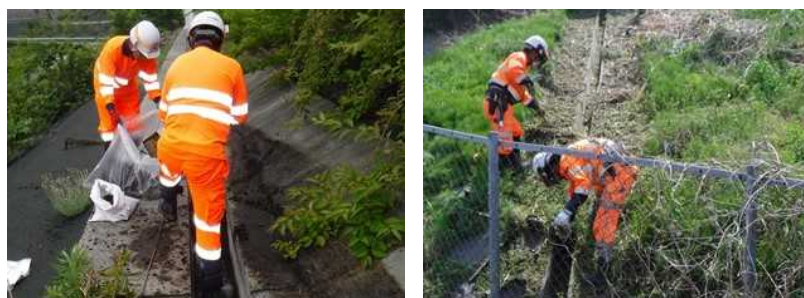
【のり面排水溝清掃状況】
