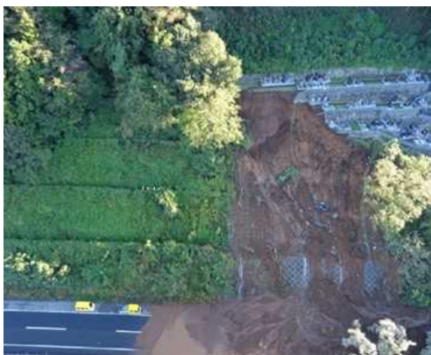
【E20 中央自動車道 上り線43. 7KP 付近】
