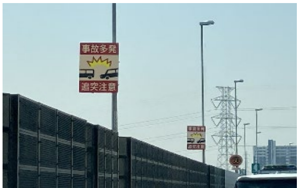
(注意喚起看板の設置状況)
