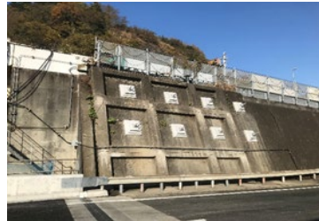
(のり面補強工事の状況)
