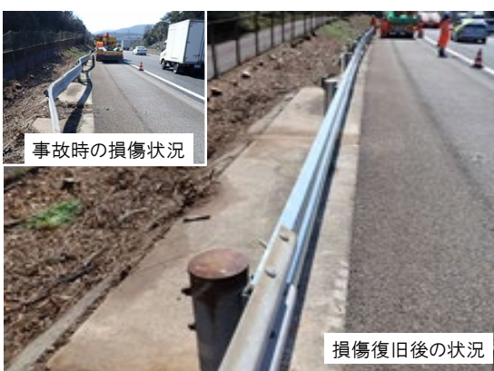
(事故復旧の状況)
