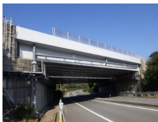
(表面被覆工の状況)
