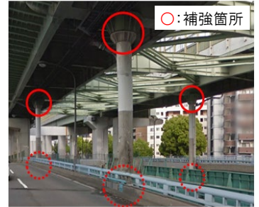
(ロッキング橋脚の耐震補強)
