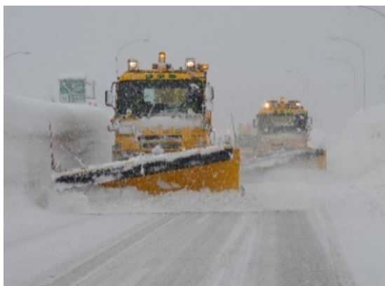
(除雪作業の状況)
