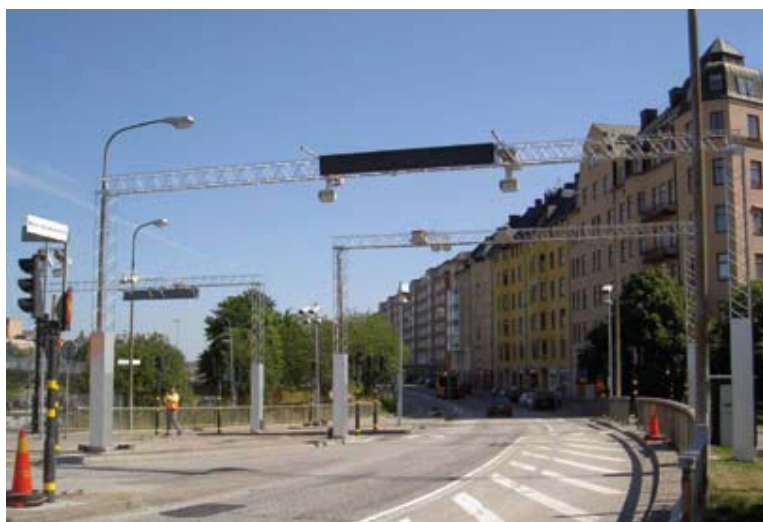
図4-3 スtockホルムのガントリーに設置された電子的タグ・リーダーとカメラ
