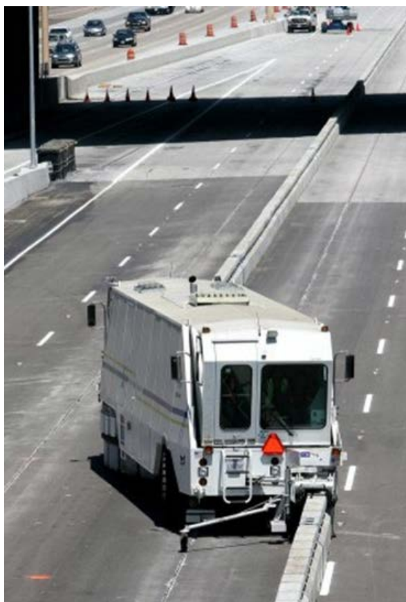
バリア移動作業車の作業の様子 (デモンストレーション)
