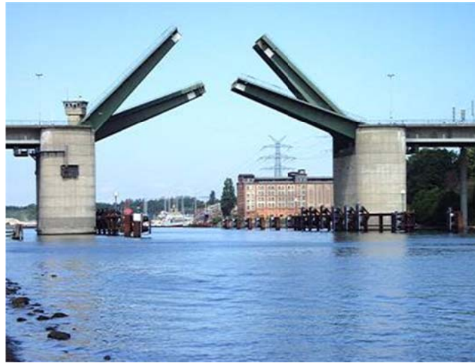
ヘレントンネル開通後の2006年に撤去されたヘレン橋（可動橋であった） （写真出典）：“Wasser-und Schifffahrtsverwaltung des Bundes”
