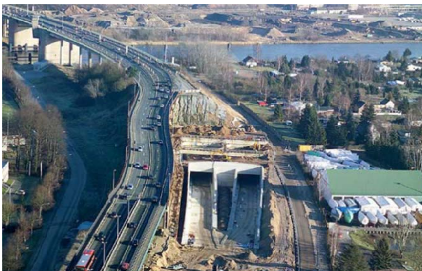
トンネル工事中写真 (写真左上方がトンネルが代替するヘレン橋)
