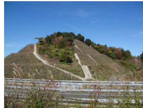
写真①（下り線側）
