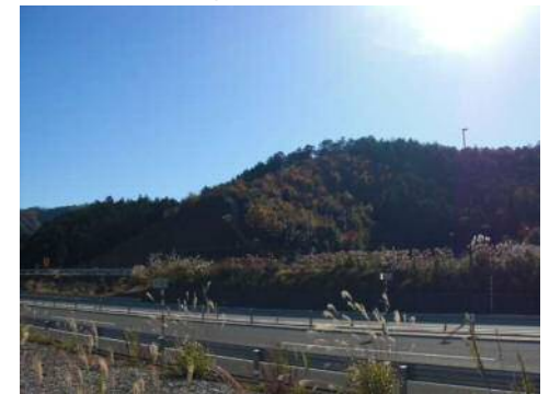
写真②（上り線側）
