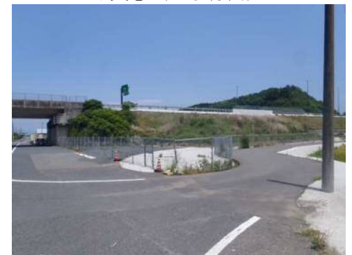
写真② (上り線側)
