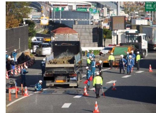
取締状況写真(出所:首都高速道路(株))
