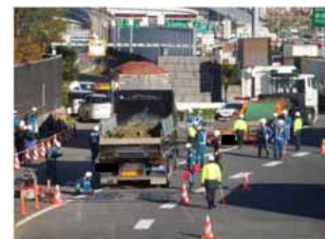
取締状況写真(出所:首都高速道路(株))
