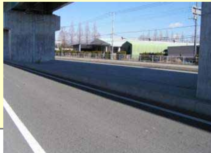
立入防止柵の省略状況
