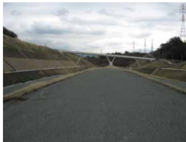
盛土完成状況
