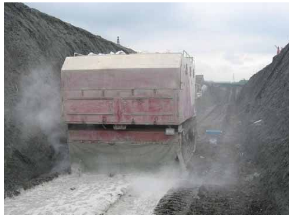
盛土箇所でのセメント混合(路上混合)
