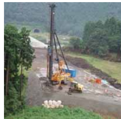
深層混合処理(セメント攪拌状況)
