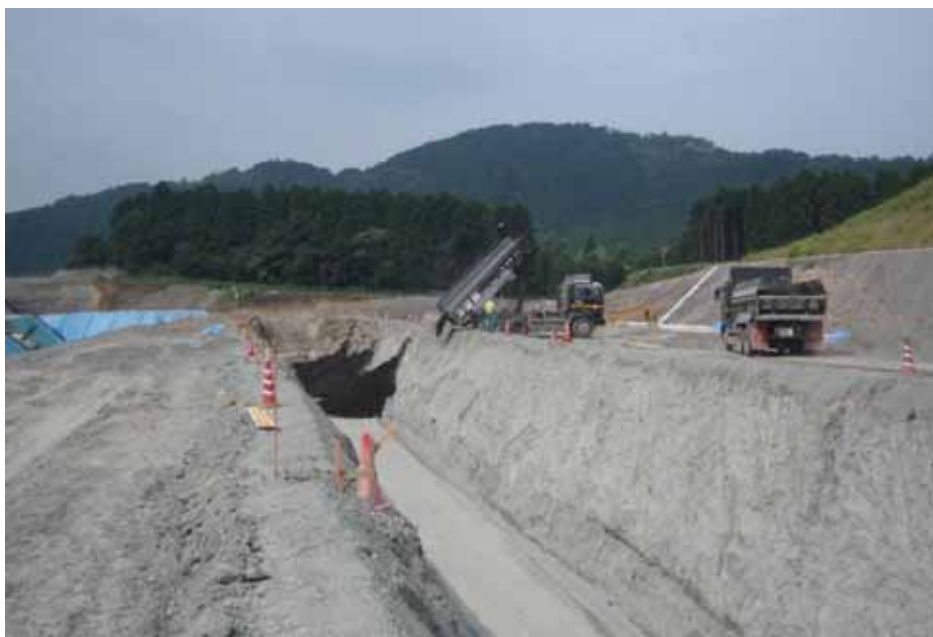
ペーパースラッジ掘削土の盛土箇所への搬入
