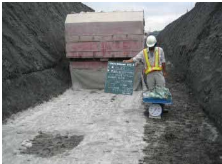
セメント添加量の確認状況
