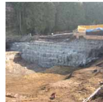
深層混合処理完了
