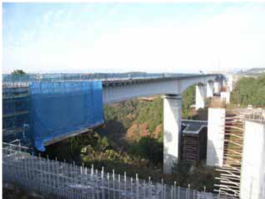
側径間部施工の状況
