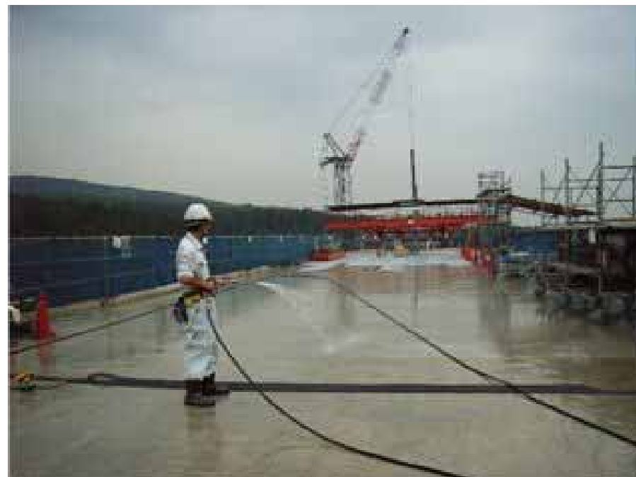
橋面散水状況
