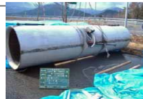
撤去したジェットファン
