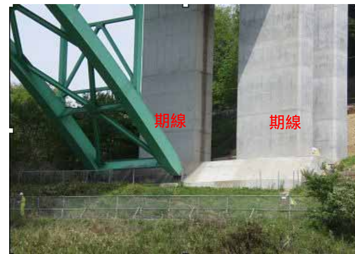
P3橋脚アーチアバット
