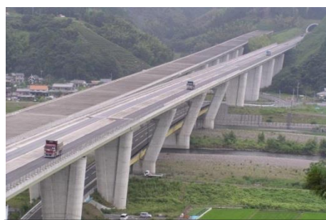
高速土運搬状況(橋梁部)
