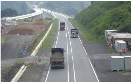
高速土運搬状況(土工部)
