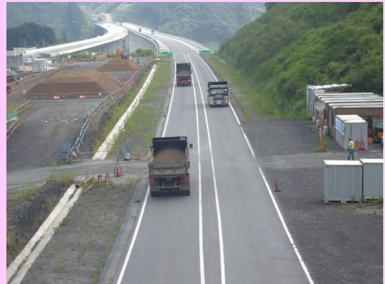
高速土運搬状況(土工部)
