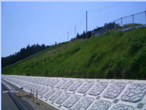
コンクリートのり砕工
