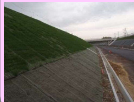
侵食防止型マット工
