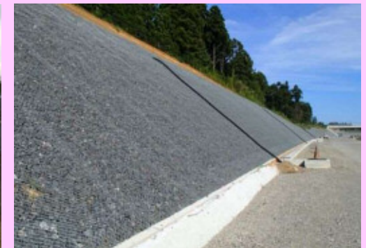
碎石のり面工
