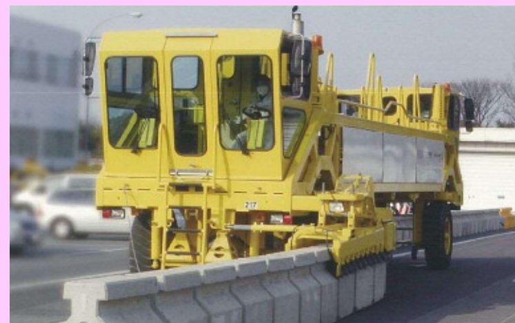
移動式防護柵切替用車両による防護柵移動状況
