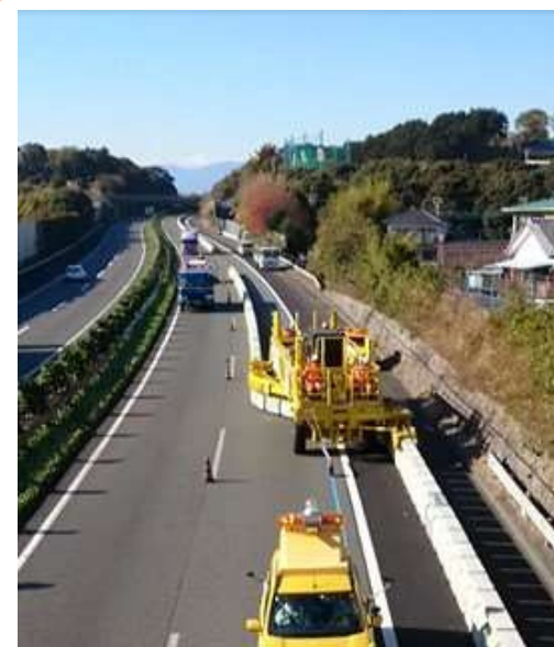
移動式防護柵移動状況 (規制設置手順③)
