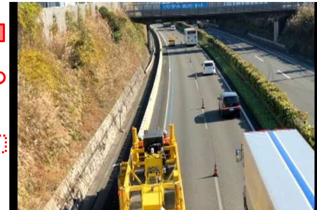
【規制設置作業状況】
