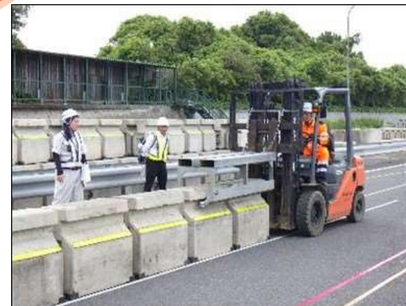
防護ブロック設置状況
