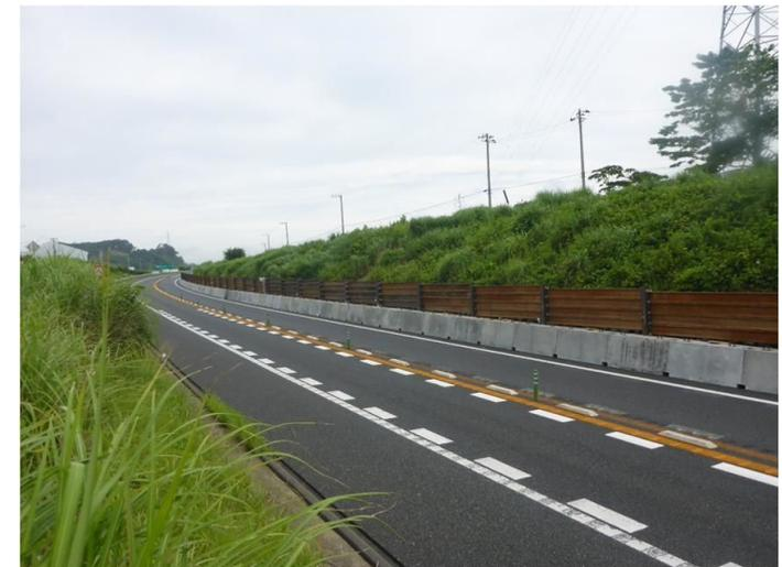
落石防護柵設置状況
