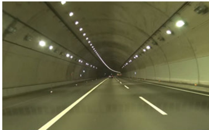
6車線化事業前の新東名高速道路のトンネル
