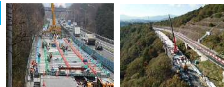
【高速道路リニューアル工事 橋梁床版の取替え工事状況】
