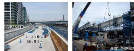
【東品川栈橋・鮫洲埋立部の工事状況】
