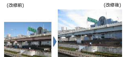
【6号向島線環通付近の高架橋の景観に考慮した橋梁桁の塗替え】
