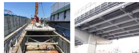
【床版取替え工事状況】
