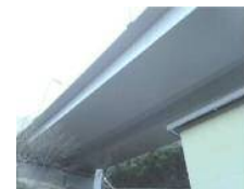
【橋梁表面被覆工の施工状況】
