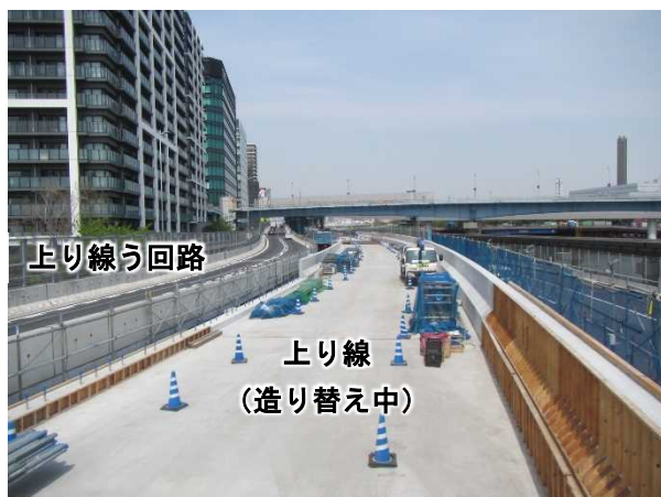
上り線造り替え工事施工状況
