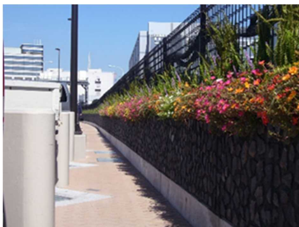
パーキングエリア内の植栽
