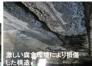
東品川栈橋・鮫洲埋立部の損傷状況
