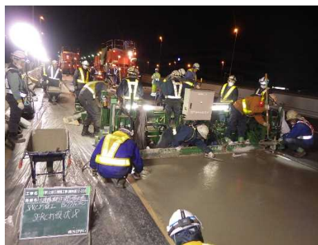
鋼床版 SFRC 舗装施工状況
