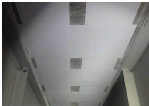
RC 床版炭素繊維補強施工状況
