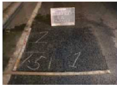
補修後（舗装の部分打換え）
