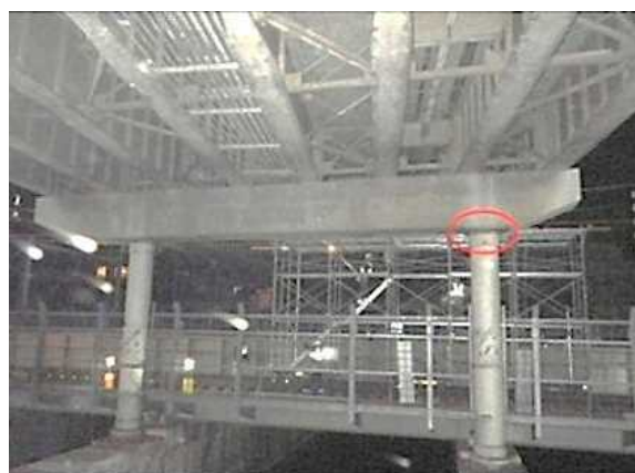
首都高におけるロッキング橋脚
