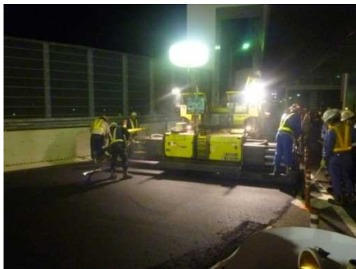
舗装工事実施状況
