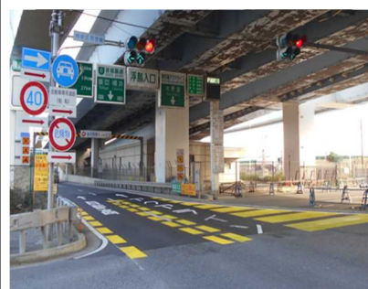
カラー路面表示 (浮島[東/西]入口)
