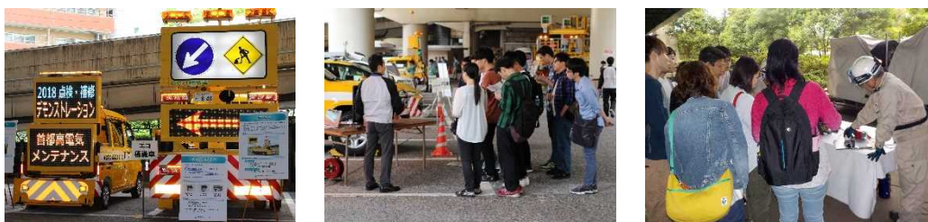
点検・補修デモ実施状況（平成30年5月）
