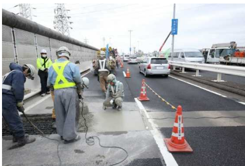
長時間車線規制工事の実施状況（ノージョイント化工事）
