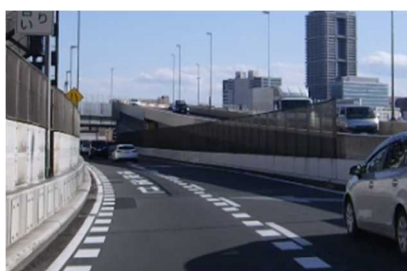
舗装打換え 減速レーンマーク
