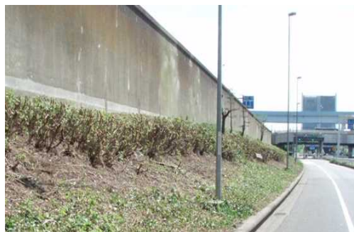
道路路肩脇の植樹の伐採後
