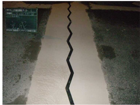
補修後（伸縮装置の取替え）
