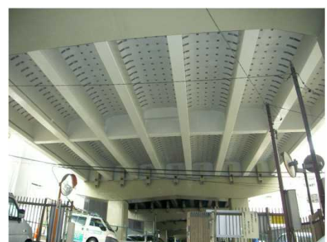
補修後（炭素繊維補強）
