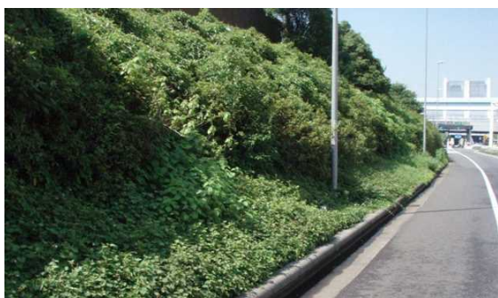
道路路肩脇の植樹の伐採前
