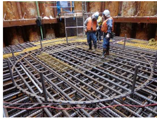
基礎・橋脚施工状況
