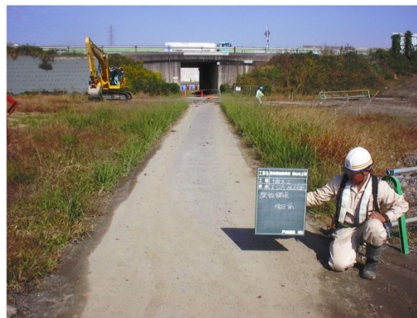
①ルートの現況
