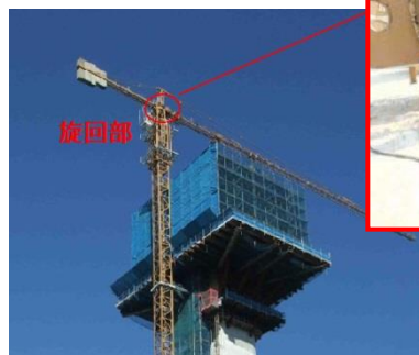
タワークレーン旋回時の安全対策
