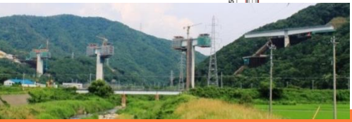
張出し架設状況
