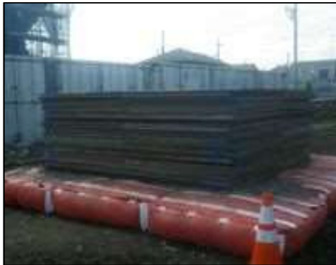
試験施工(載荷試験)
