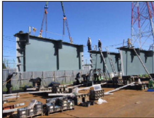
主桁の地組状況
