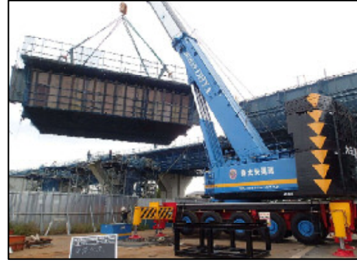
クレーンによる架設状況
