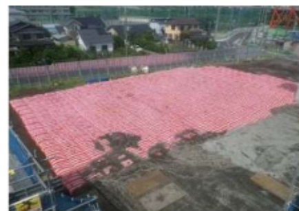
地盤改良施工後
