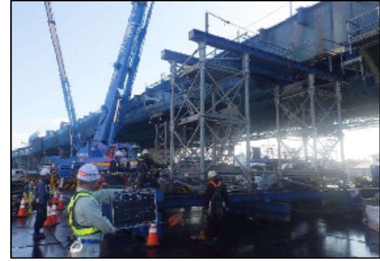
クレーンによる架設状況
