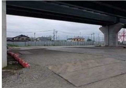
施工後に、碎石・敷鉄板を敷設
