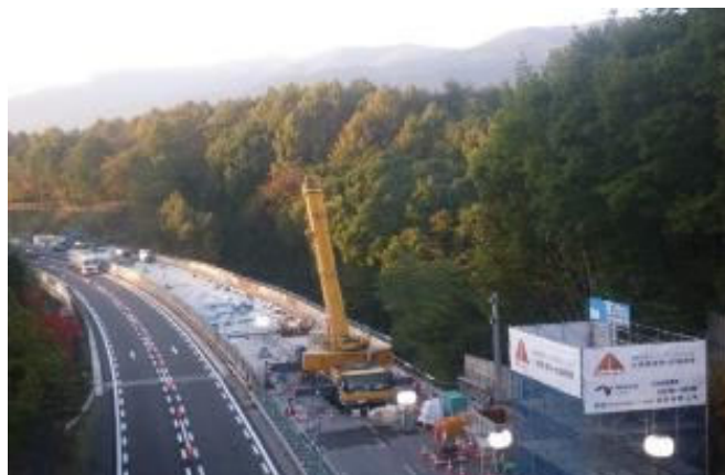
【床版取替施工状況】
