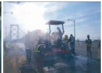
《基層グースAS舗設》
