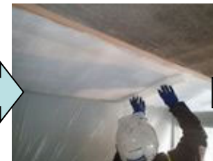
シート接着工
