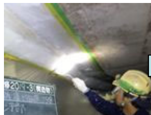
接着材塗布工
