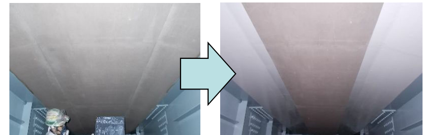
剥落防止施工前
