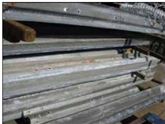
発生材(ガードレール)の選別
