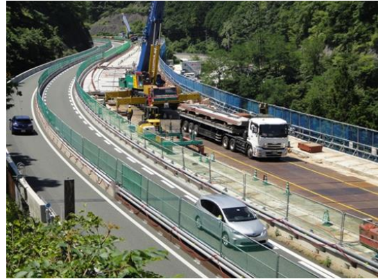
対面通行規制による施工状況例
