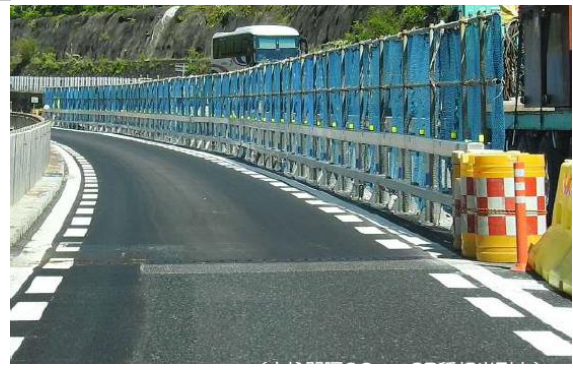
鋼製防護柵 現地設置状況
