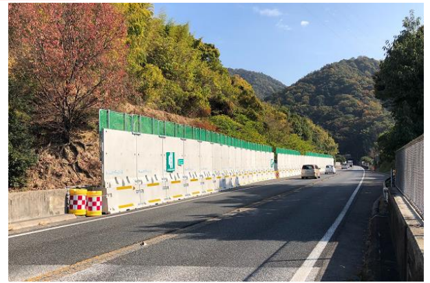
仮設防護柵設置イメージ
