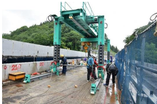
架設機械(門型クレーン)
