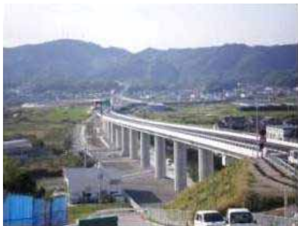
みなべ高架橋
