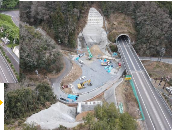
ため池盛土後
