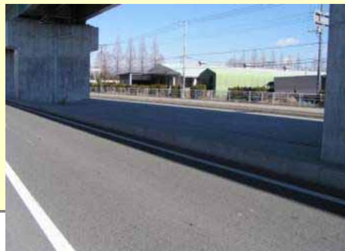
立入防止柵の省略状況
