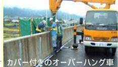
落下物防止柵設置施工図
