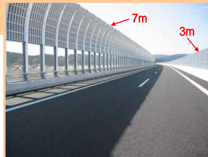
7m、3mの設置状況
