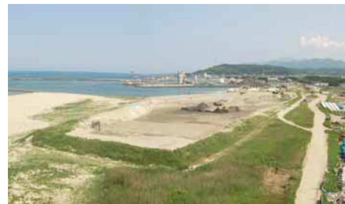
浚渫砂の状況
