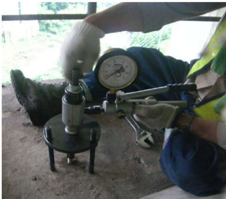
突梁用アンカー引抜試験 18N以上でOK
