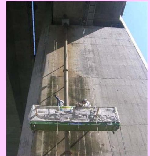
ゴンドラ工法による排水管取替えの状況
