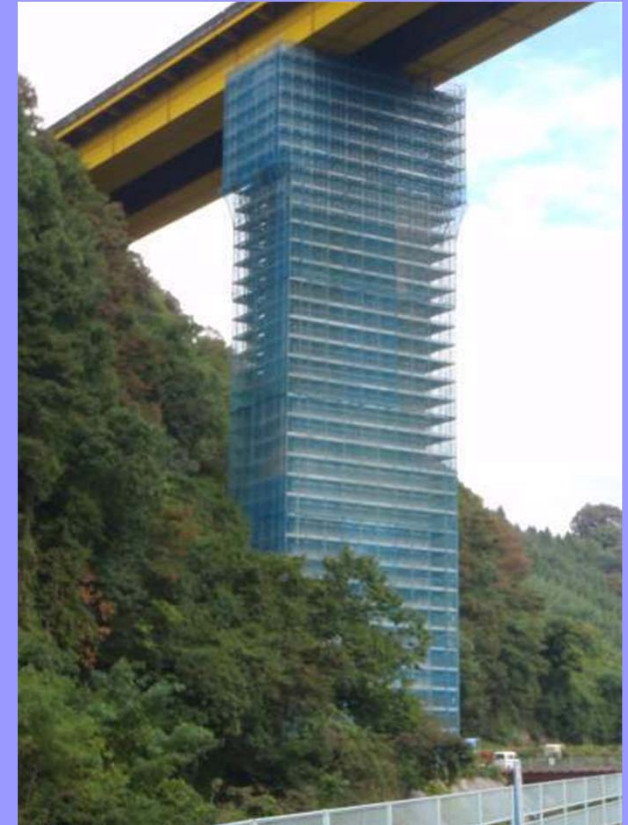
一般構造物用足場を設置した例
